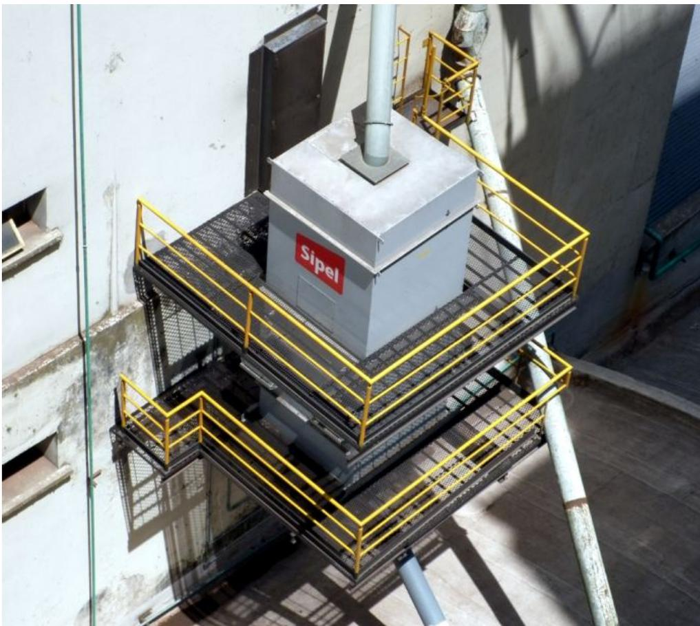
El Sistema de Pesaje Continuo de Sipel, es la mejor alternativa para cuantificar con exactitud la carga y descarga de cereales, semillas, polvos y demás materiales. Con precisión mayor al 99,3% y la posibilidad de auto-calibración. Producido en Argentina asegura un servicio post-venta de excelencia y precios razonables durante toda la vida útil del producto.
